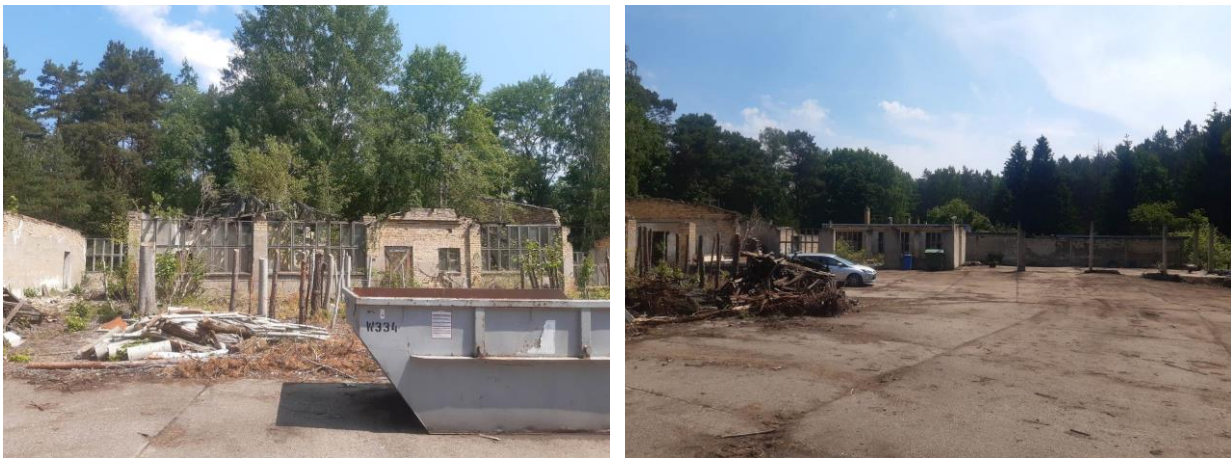
Abb. 1: Teilansicht der Gebäudereste am nördlichen Grundstücksrand (links) und Ostseite (rechts)
