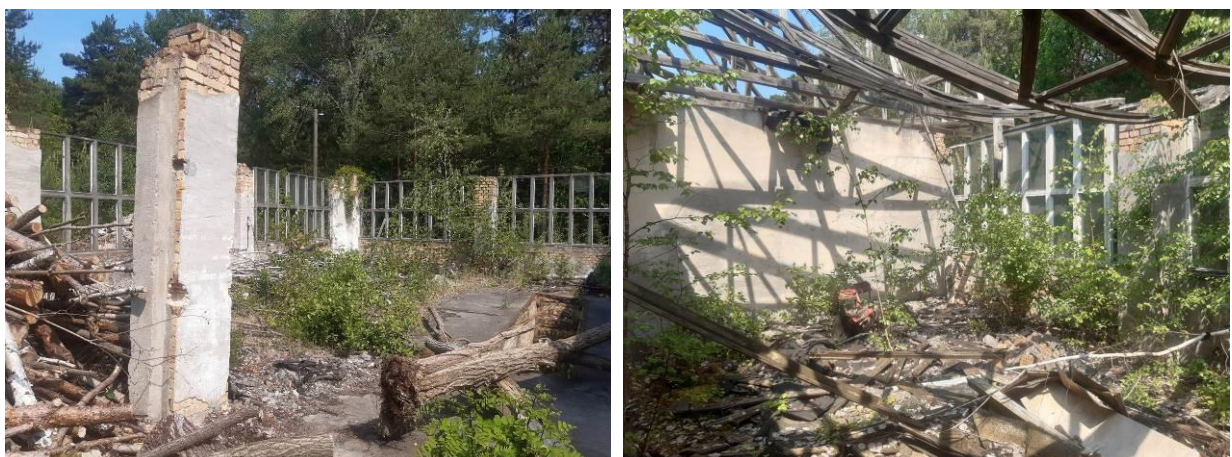
Abb. 2: Detailansicht der nördlichen Gebäudereste
