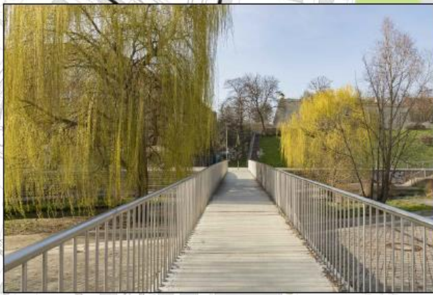
BEISPIEL: Fußgängerbrücke (Erfurt)
