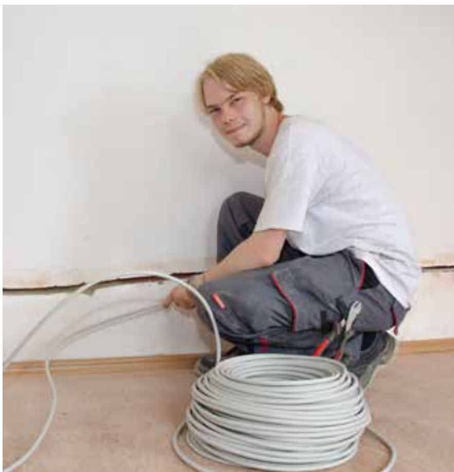
Daniel Schulze beim Ziehen eines Kabels. Der 18-Jährige aus Zittau hat gerade sein 2. Lehrjahr als Elektriker begonnen. Er mag die Abwechslung in seinem Lehrberuf. (Foto: Handwerkskammer Dresden/Linda Wolter)
