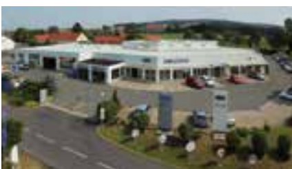
Autohaus Löbau GmbH
